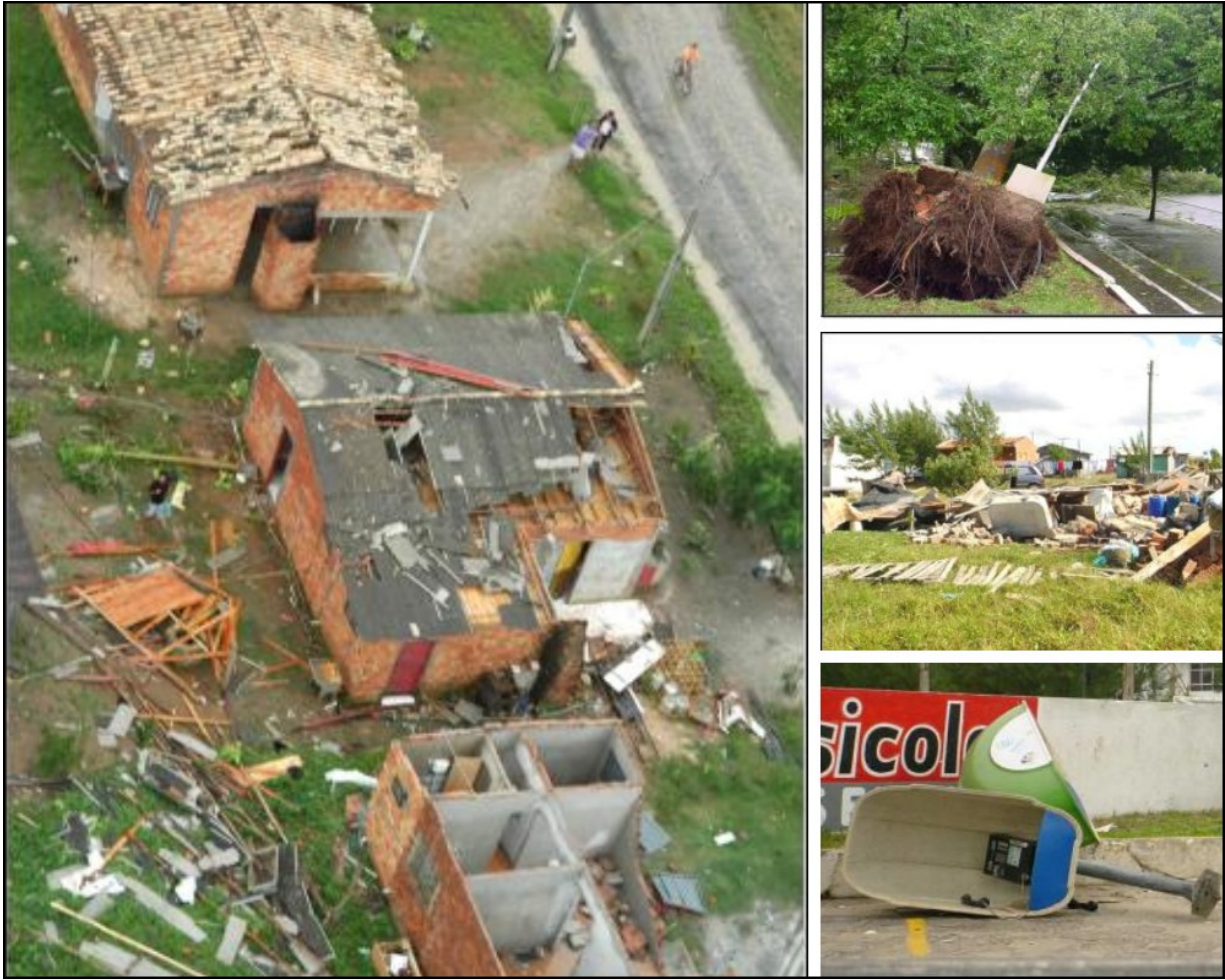
Dans la partie sud de l'État, des maisons entières ont été pratiquement rayées de la carte (Crédit photo : Frederico Rudorff / Divulgação)
