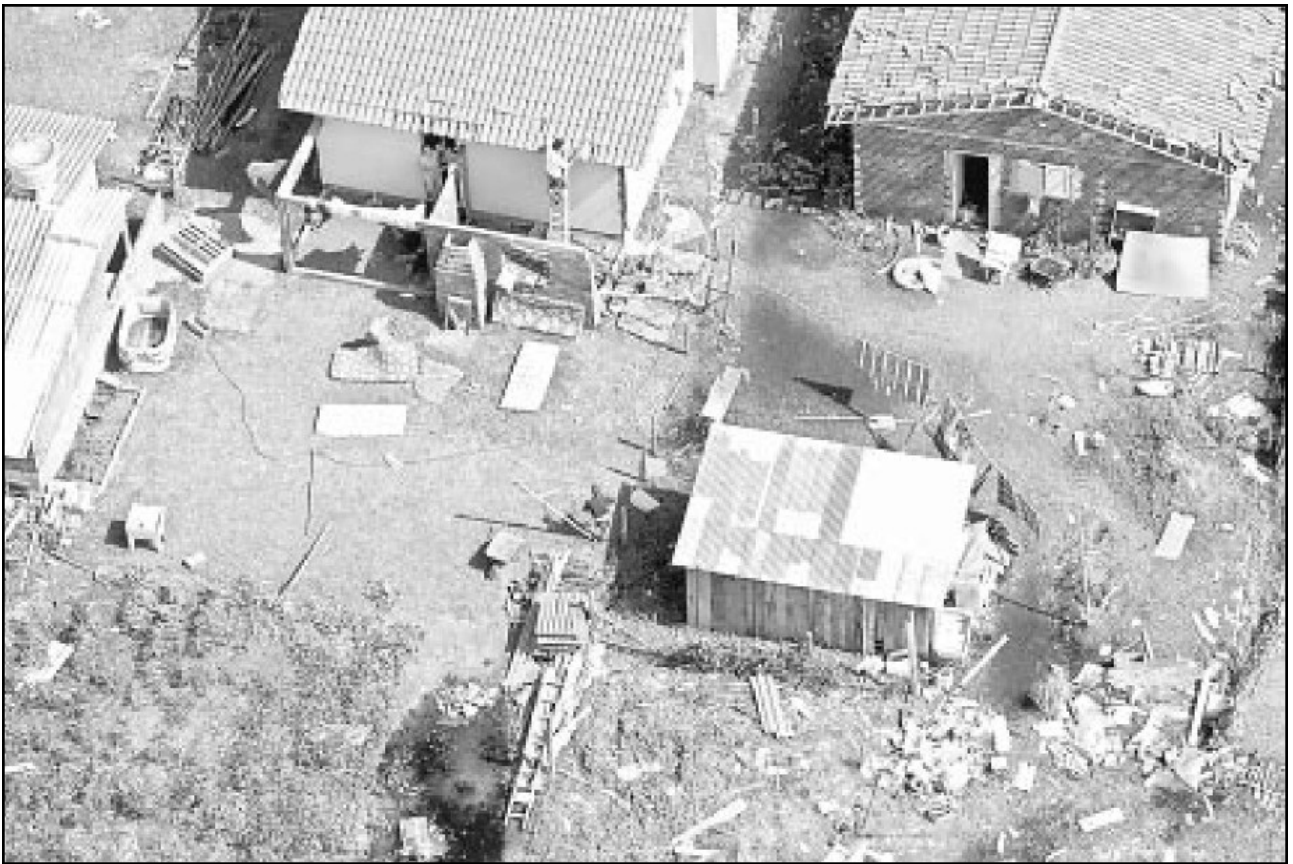
Un habitant de Passo de Torres utilise une échelle pour évaluer les dégâts sur le toit (Photo issue du journal « Diário Catarinense » du 29/03/2004)
