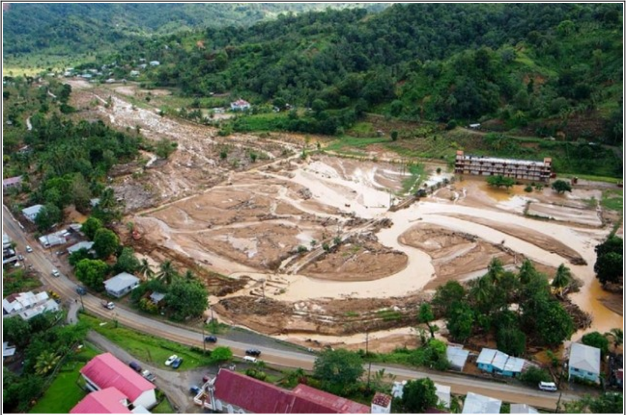
Coulée de boue dans la vallée de Bexon
