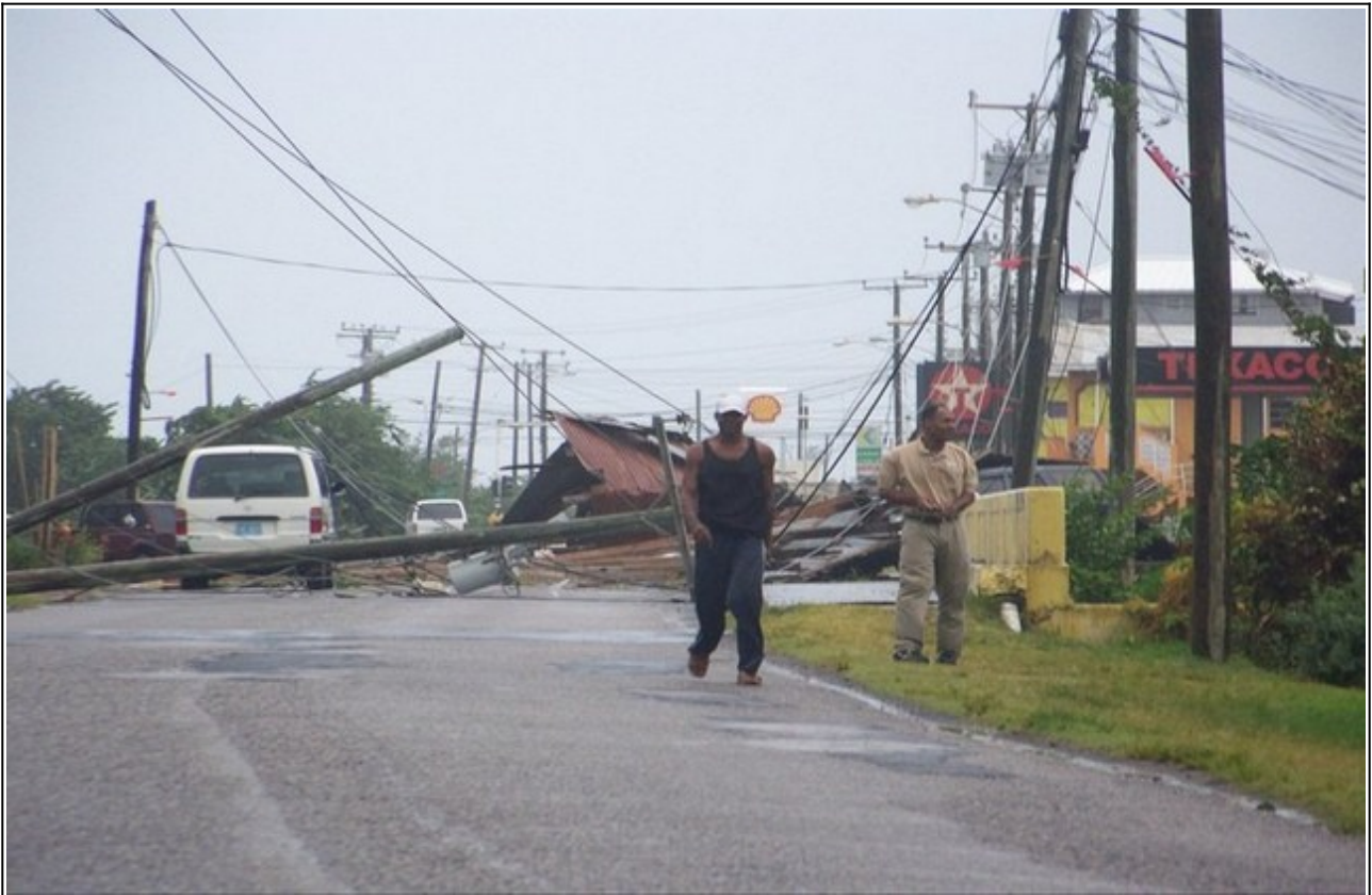
Dégâts dus au vent dans la localité de Vieux-Fort
