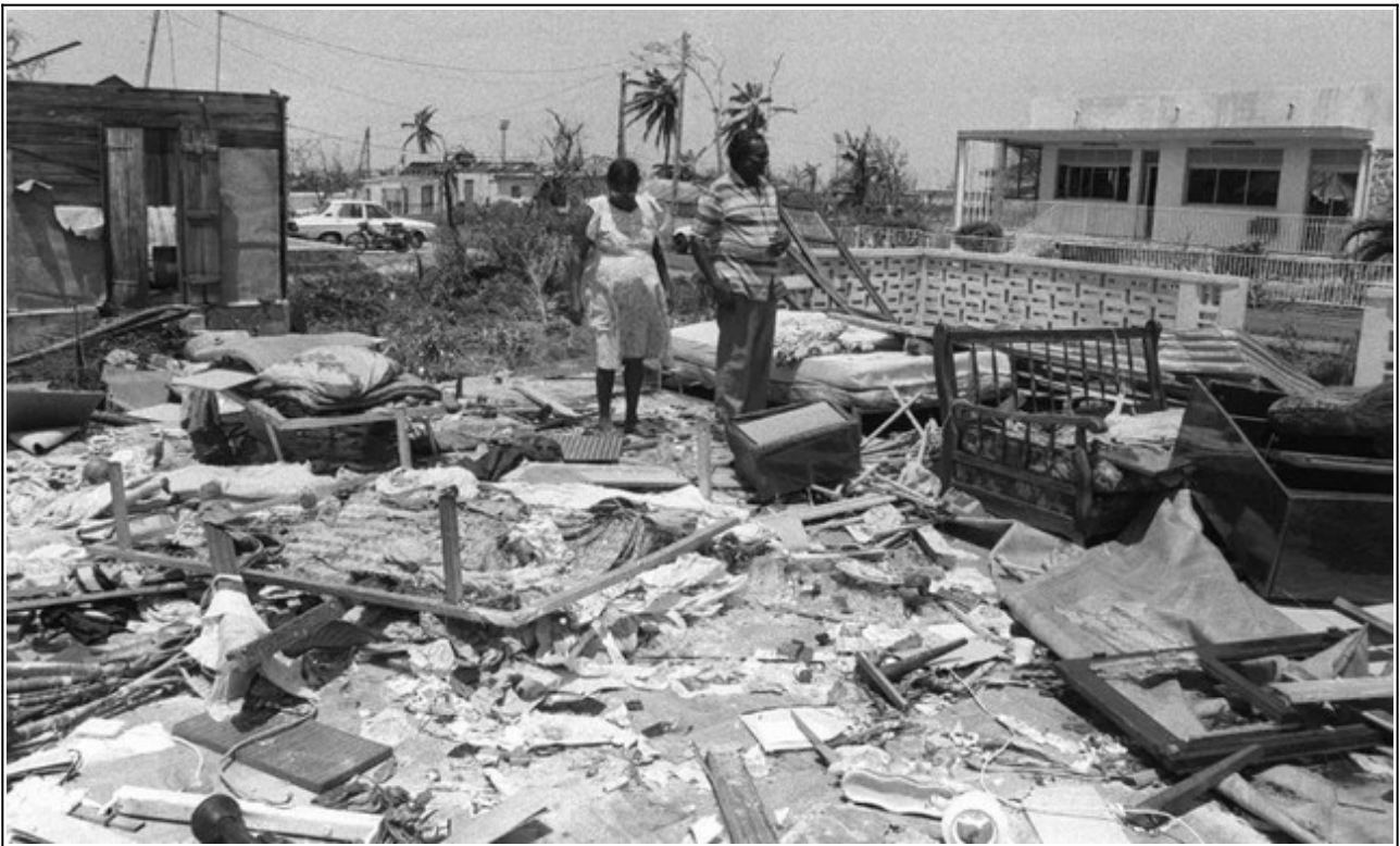
Restes d'une maison dans la commune de Saint-François (Crédit photo : France-Antilles)
