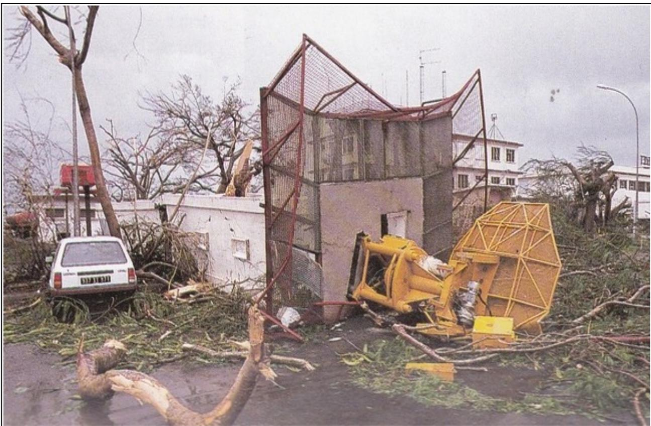
*À l'aéroport du Raizet, le radar météorologique et sa tour en béton qui le soutenait brisés par le vent vers 0 h 30 locales, alors que l'œil de HUGO se trouvait sur l'est de la Grande-Terre
