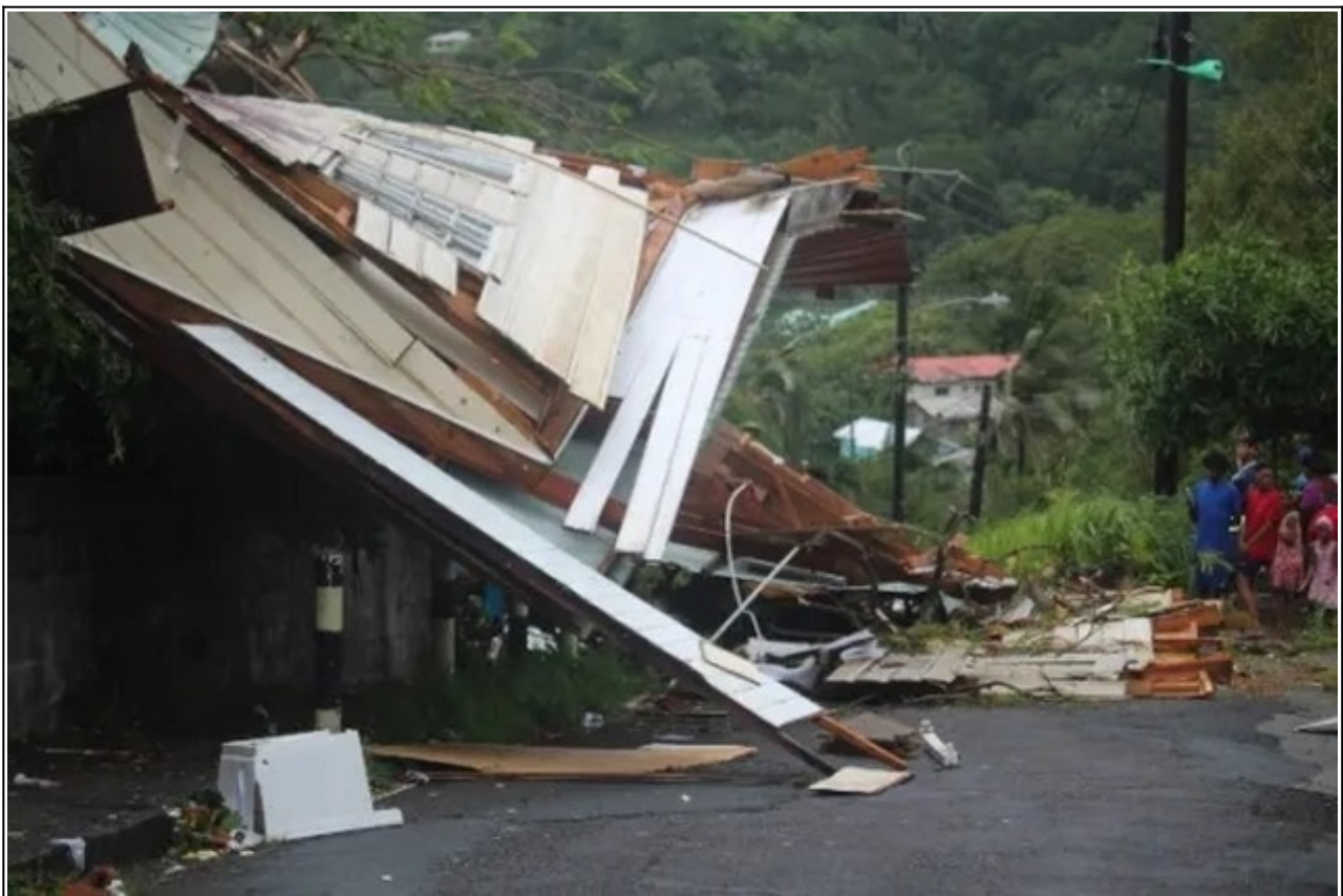
École détruite à Castries (Crédit photo : The Star)
