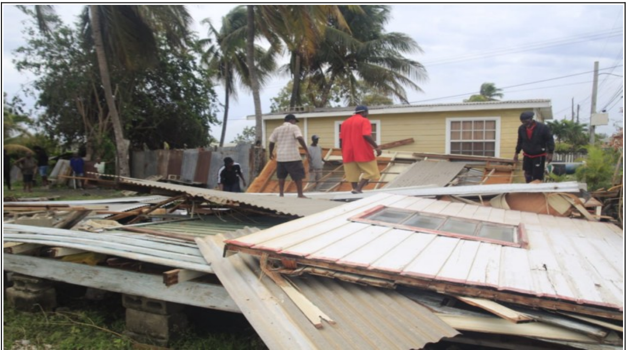
Maison détruite à Christ-Church (Crédit photo : Barbados Today)
