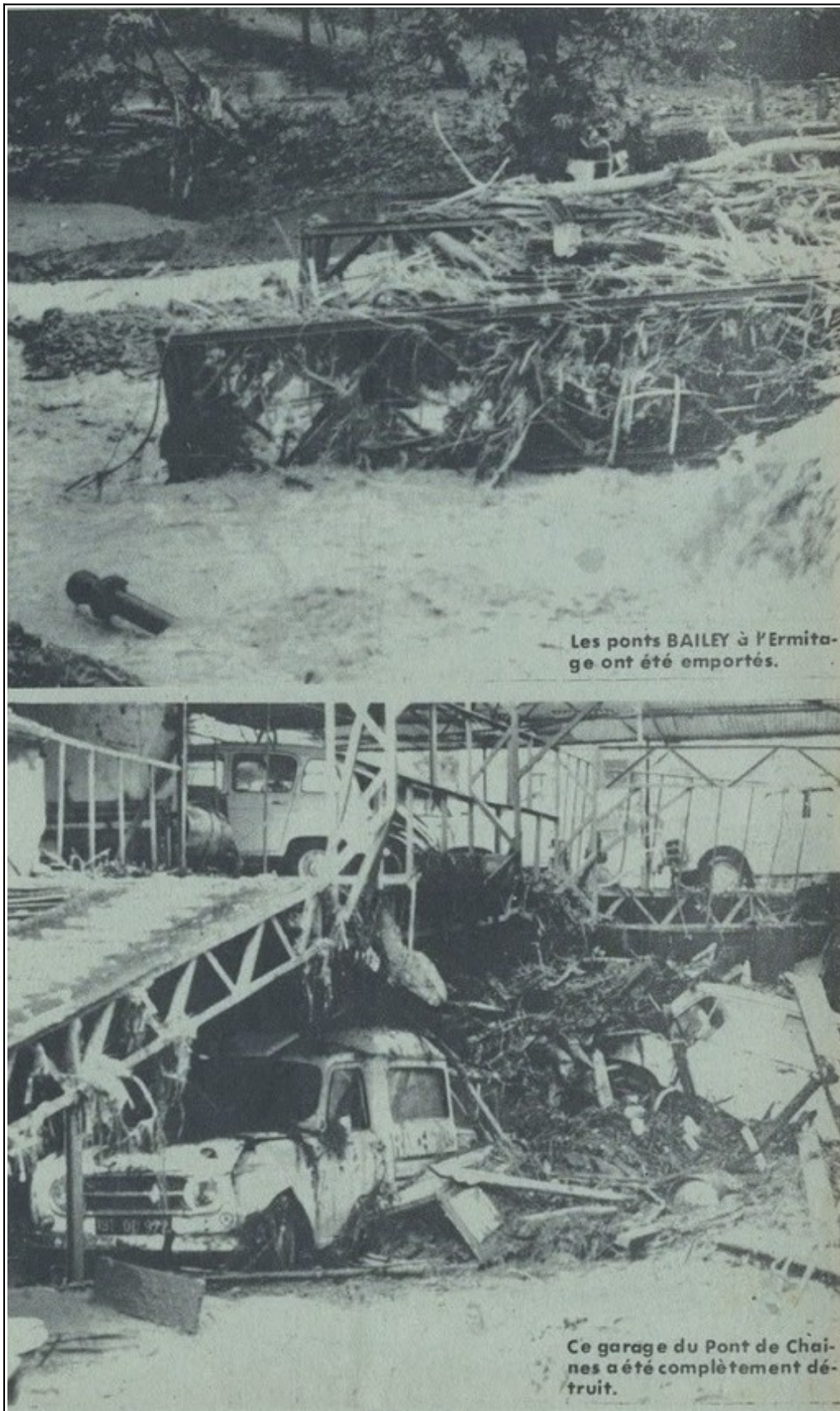
Fort-de-France Les ponts BAILEY à l'Ermitage (en haut) Garage au Pont de Chaînes (en bas)
