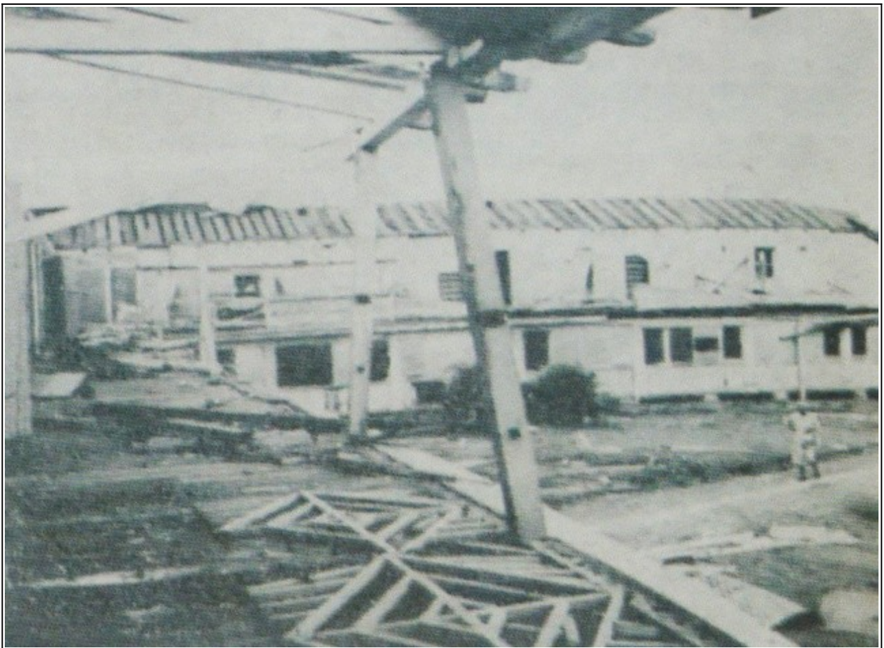
Pensionnat de Versailles à Basse-Terre (Crédit photo : Archives départementales de la Guadeloupe)
