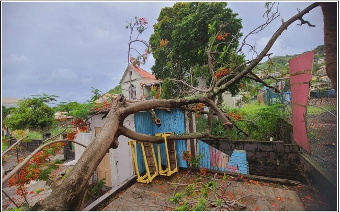
Dégâts à Saint-Vincent Crédit photo : journal The St. Vincent Times)
