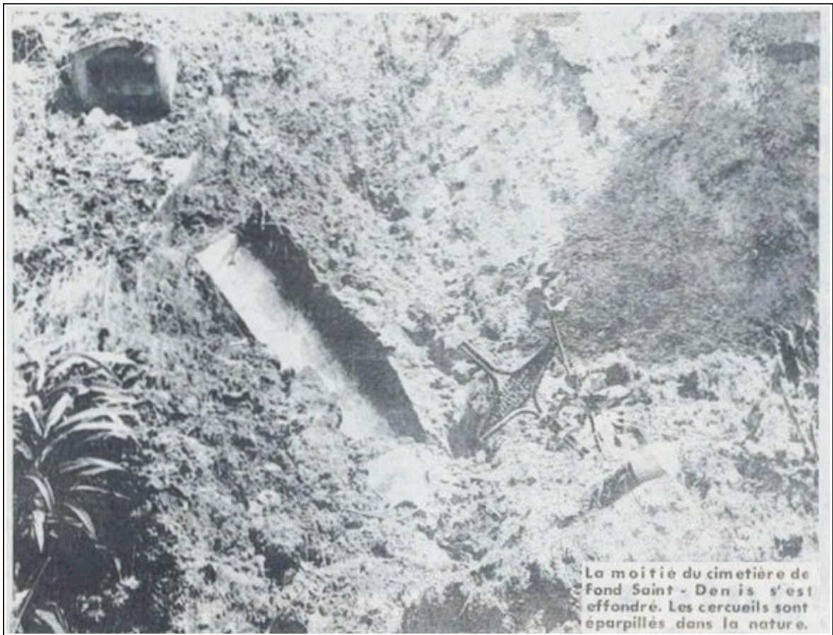
Cimetière de Fonds-Saint-Denis effondré et dévasté
