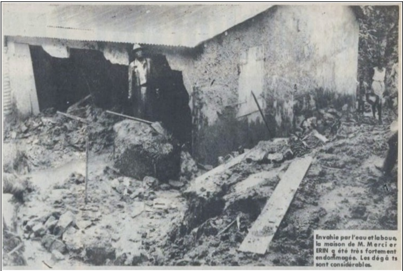
Fonds-Saint-Denis - Maison envahie par l'eau et la boue
