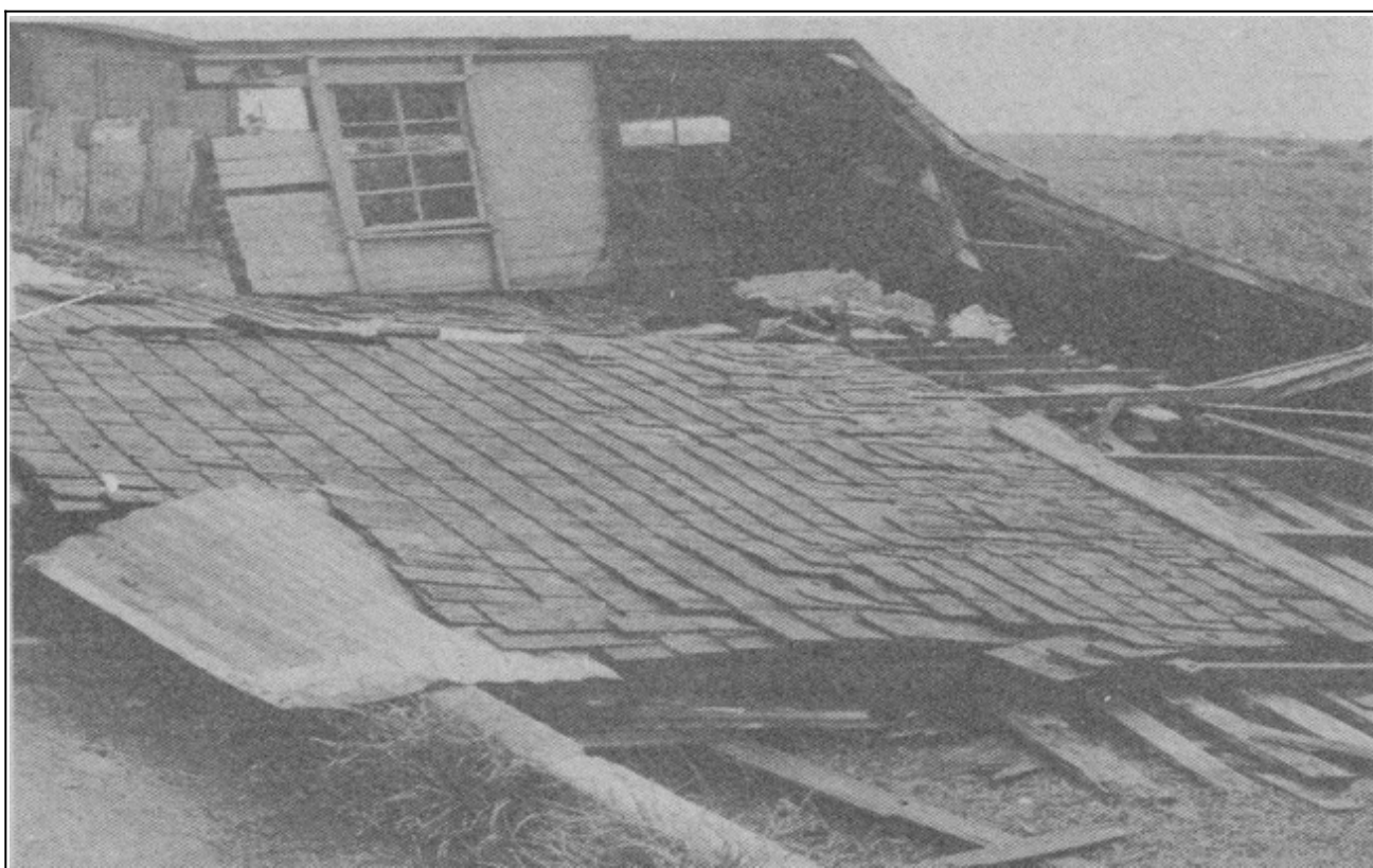
Habitation à Christ Church dans le sud de l'île
