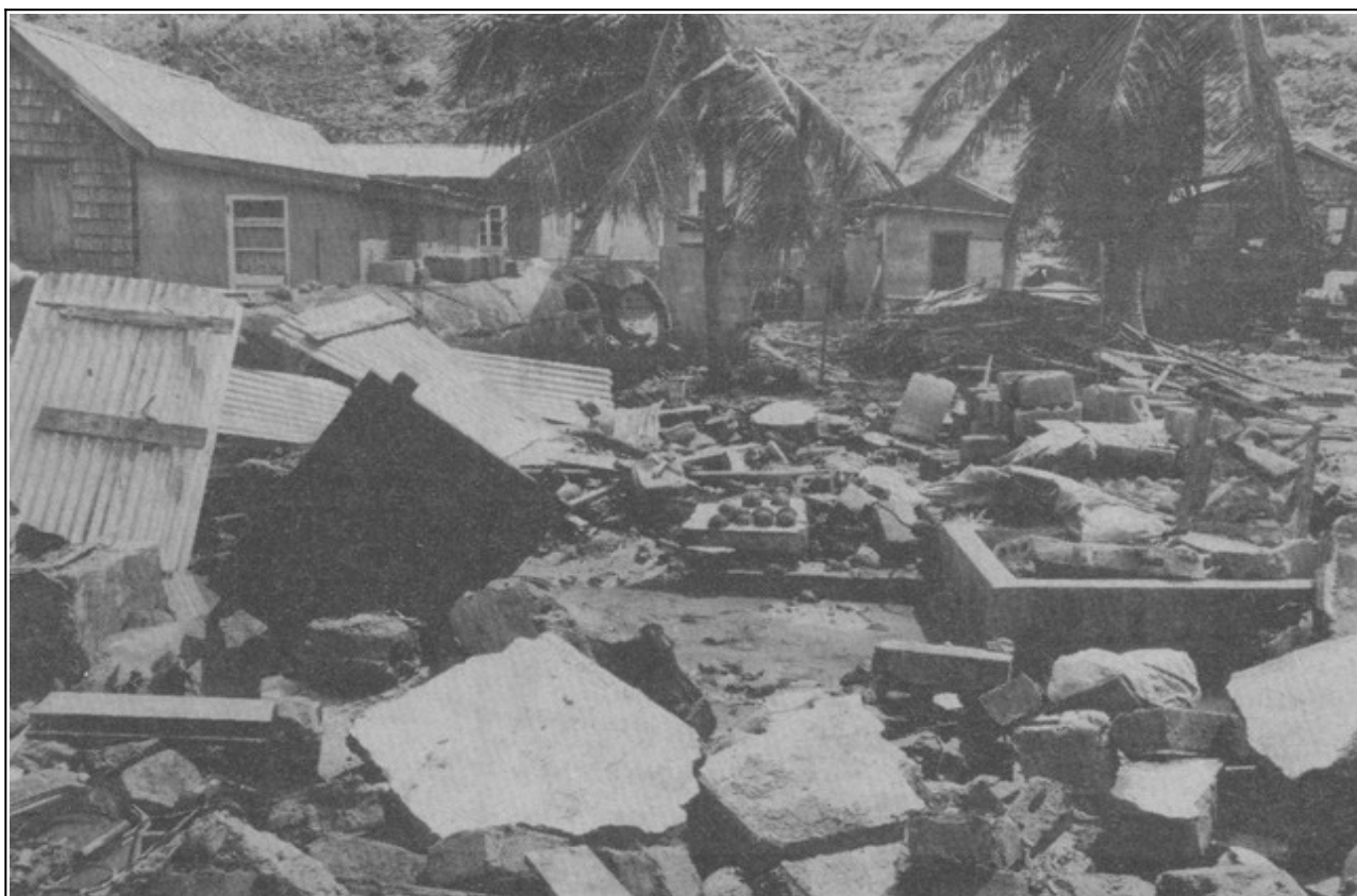
Destructions à Vieux-Fort dans l'extrême sud de l'île
