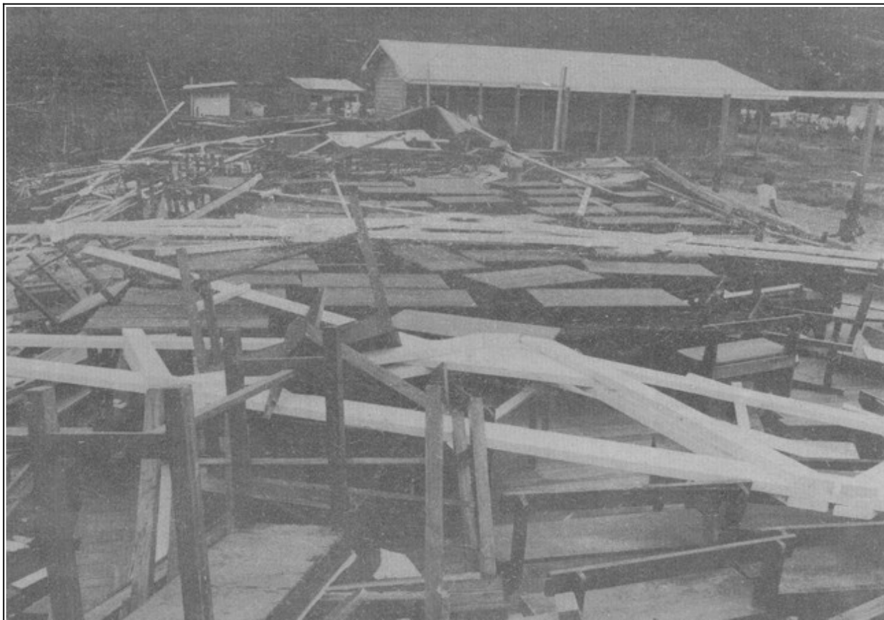
Restes d'une école de Richfond à Dennery
