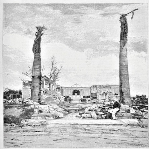
EGLISE DU MORNE-ROUGE APRÈS LE CYCLONE.
